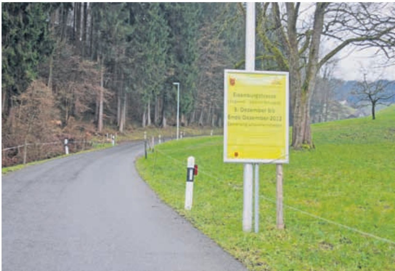
Ist bereits im Gange: die Sanierung als Folge von Unwetterschäden an der Eisenburgstrasse.
